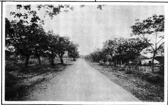
Un aspecto de la carretera de Piedrecitas, asfaltada por el Gobierno, y que forma parte del plan de Obras Públicas nacionales.
